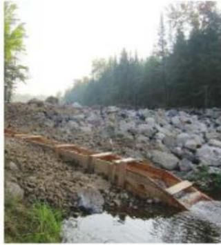
**Par Accès** – La firme de consultants en environnement BIOFILLIA a fait un bilan positif suite à la construction d'une échelle à poissons à Wenworth-Nord dans les Laurentides cet été. L'ouvrage en bois et en pierres permettra aux nombreux poissons de gravir un dénivelé de plus de deux mètres pour atteindre le vaste réseau hydrographique du lac St-Victor situé en amont.
